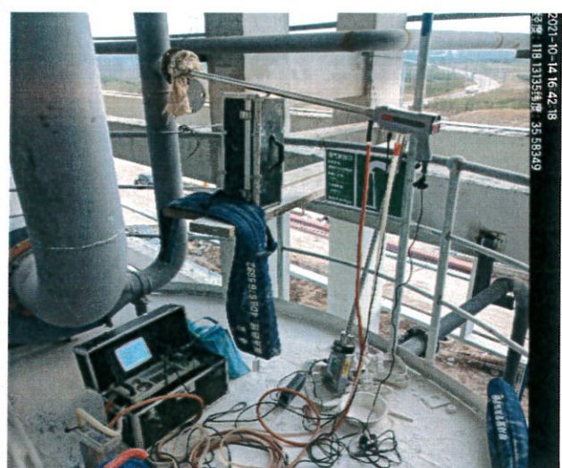
附图 2 石灰仓废气采样
